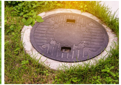
Couvercle mal dégagé qui occasionne un déplacement inutile
